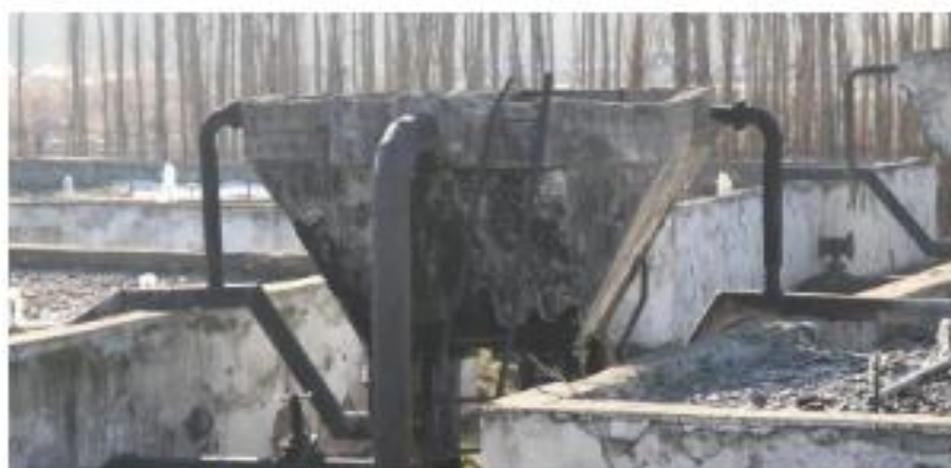
Рис. 4 Распределительная чаша системы аэробных биологических фильтров города Джамал-Абад
